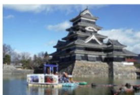
1. お堀の堆積土を吸い上げる
