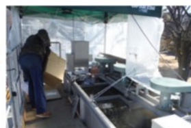
2. オイルフロックを投入攪拌 【90m濁水処理機】
