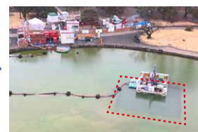
施工完了箇所
